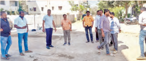
సి.సి.రోడ్డు నిర్మాణపు పనులను పర్యవేక్షిస్తున్న కార్పొరేటర్ లభిరెడ్డి.
