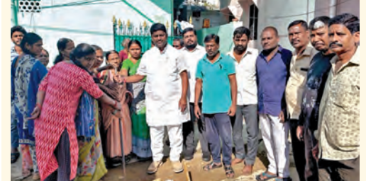
5వ వార్డు వాల్మీకి నగర్లో రోడ్డు పనులను ప్రారంభిస్తున్న బోర్డు మెంబర్ రామకృష్ణ తదితరులు
